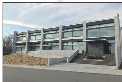
情報・システム研究機構 データサイエンス棟
